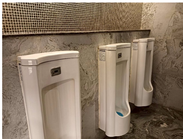
รูปที่ 2.11 สุขภัณฑ์ที่ประหยัดน้ำ และสามารถปรับระดับน้ำที่ใช้ได้ (วันที่ 20 ธ.ค. 2568)
