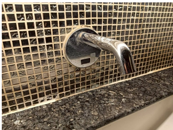
รูปที่ 2.11 สุขภัณฑ์ที่ประหยัดน้ำ และสามารถปรับระดับน้ำที่ใช้ได้ (วันที่ 20 ธ.ค. 2568)
