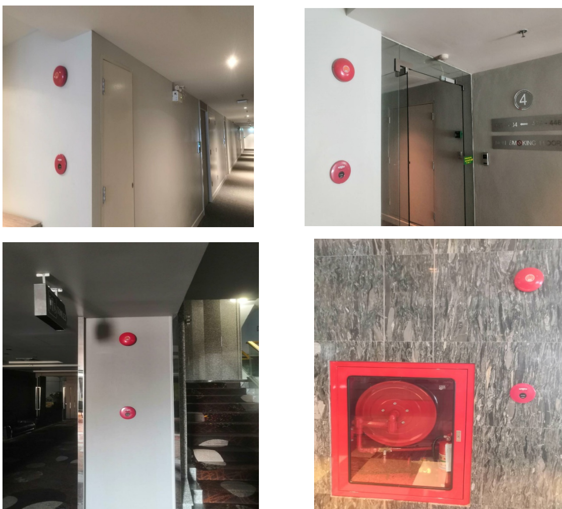
รูปที่ 2.26 เครื่องแจ้งเหตุโดยใช่มือกด และกริ่งสัญญาณเตือนภัย (วันที่ 20 ธ.ค. 2568)
